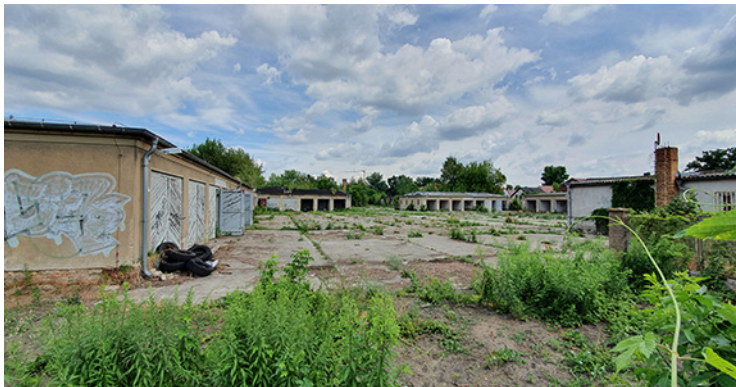
Das besagte Grundstück in der Rheinpfalzallee.
