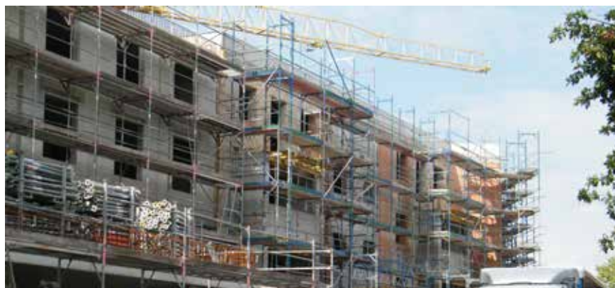
414 Wohnungen baut die HOWOGE an der Treskowallee. Zwei Senioren-Wohngemeinschaften, eine Kita mit 90 Plätzen und mehrere Geschäfte werden ebenfalls entstehen. Fotos: Peter Müller
