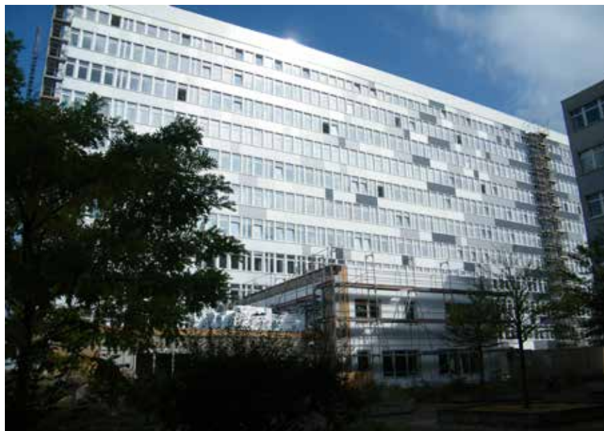
Das Q 99 in Hohenschönhausen. Insgesamt 351 Wohnungen, davon 77 für gemeinnützige Träger, sowie eine Kita mit 99 Plätzen entstehen in dem ehemaligen Bürogebäude an der Gehrenseestraße.
