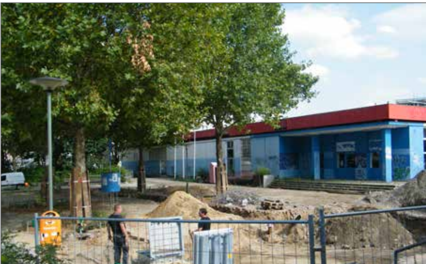
Die Bauarbeiten zur Neugestaltung des Brunnens am Mühlengrund haben begonnen. Das Interesse der Anwohnerinnen und Anwohner ist groß.
